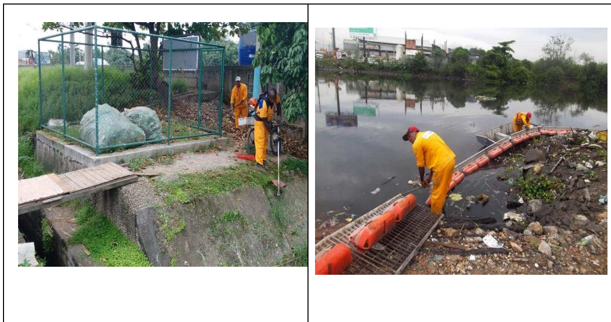
Figura 8: Serviço de limpeza da base operacional (à esquerda) e de manutenção das ecobarreiras (à direita).
