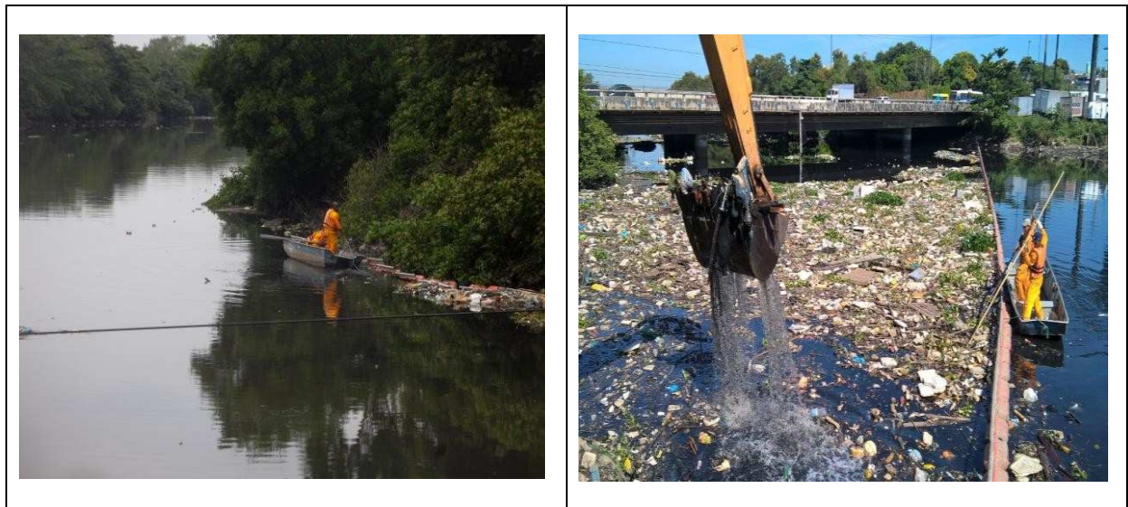
Figure 7: Serviço de apoio manual com uso de barco para a retirada de lixo nas ecobarreiras metálicas.
